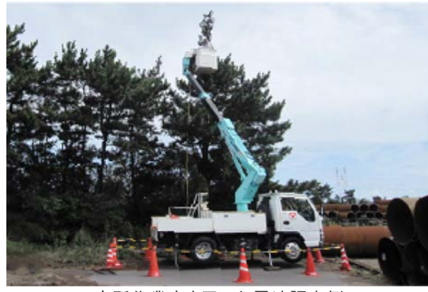
高所作業車を用いた電波調査例
